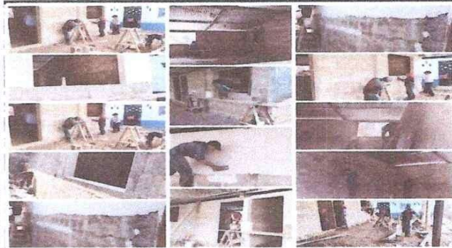
Foto 9: Reparación de repello y cernido
