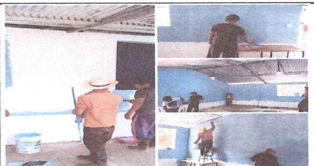
Foto 5: Pintura en muros interior y exterior dos aulas
