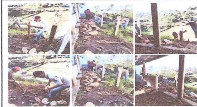
Foto 7: Muro perimetral block y malla
