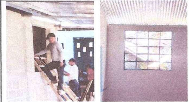
Foto 2: Ventanas de metal con vidrio
