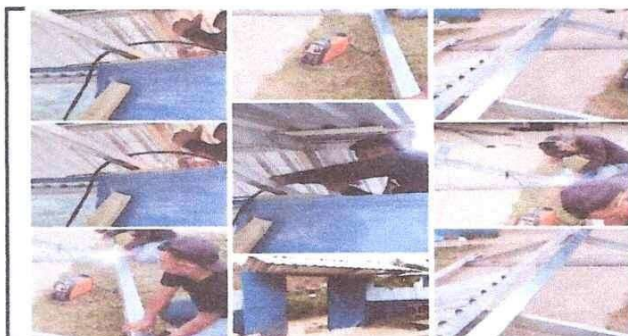
Foto 6: Mantenimiento a portón
